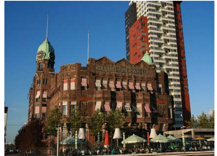
Hotel New York, 1901. Architecten J. Müller en Droogleeper Fortuin, Wilhelminapier, Rotterdam
